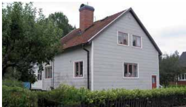
Lejoncronas väg 8, Söderfors, 1947
