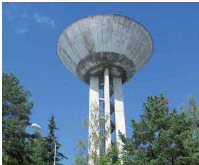
Karlholms vattentorn, Nöttövägen, 1960
