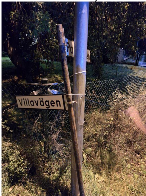
Bild V: Gatuskyltar med reparationsbehov.
