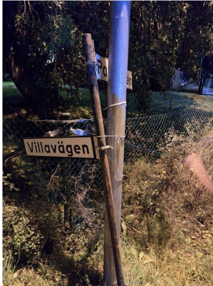
Bild V: Gatuskyltar med reparationsbehov.
