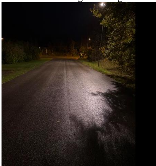
Bild Z: Vägmarkeringar saknas.
