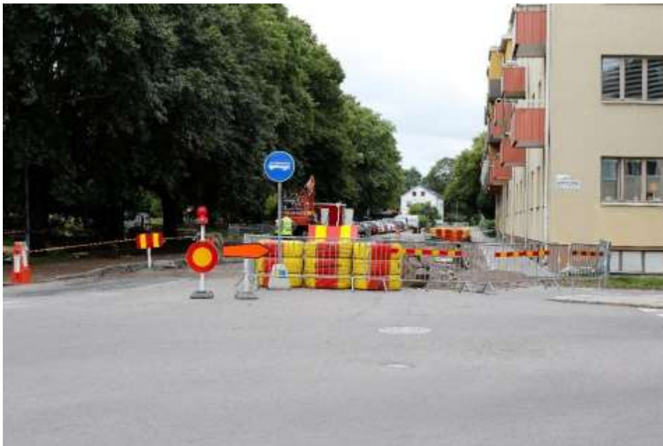
Exempel på omledning av trafik vid schaktarbete.
