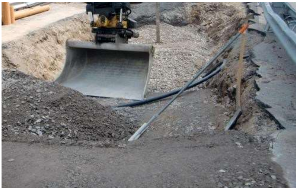
Schakt ska utföras med betryggande säkerhet mot ras och skred.
