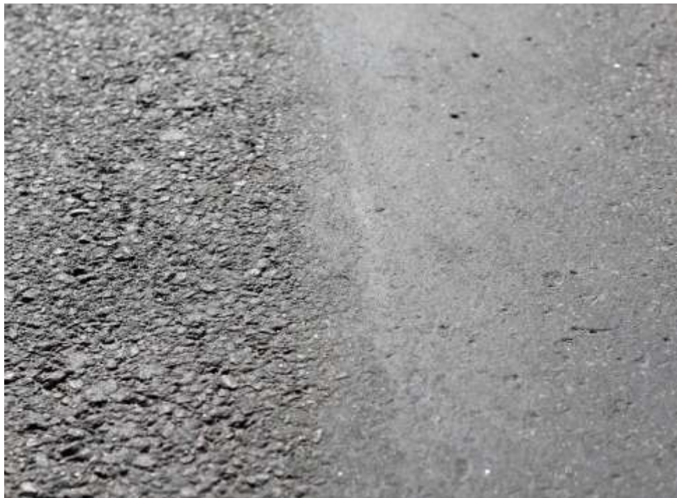
Förseglad beläggningsskarv
