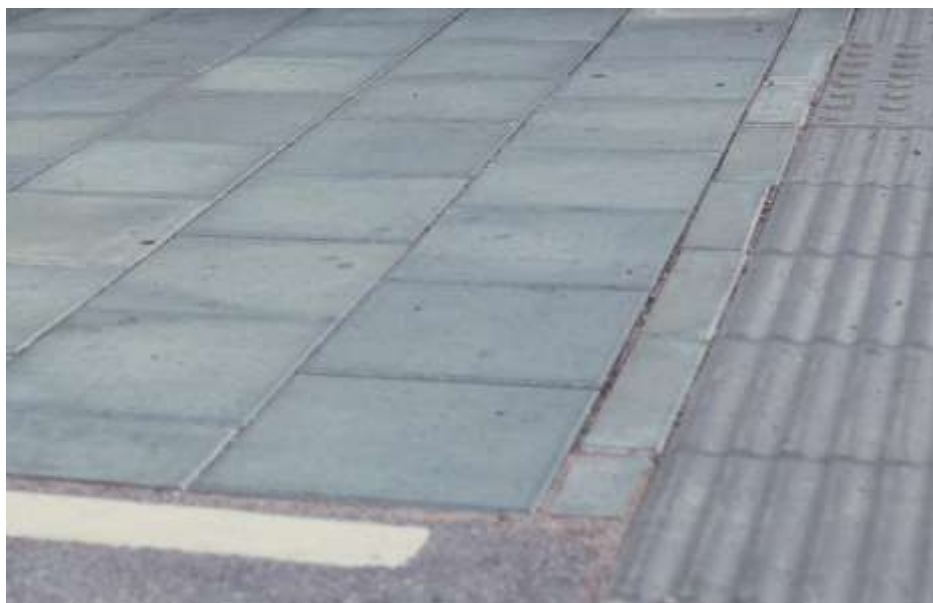
Återställning av plattor efter schakt
