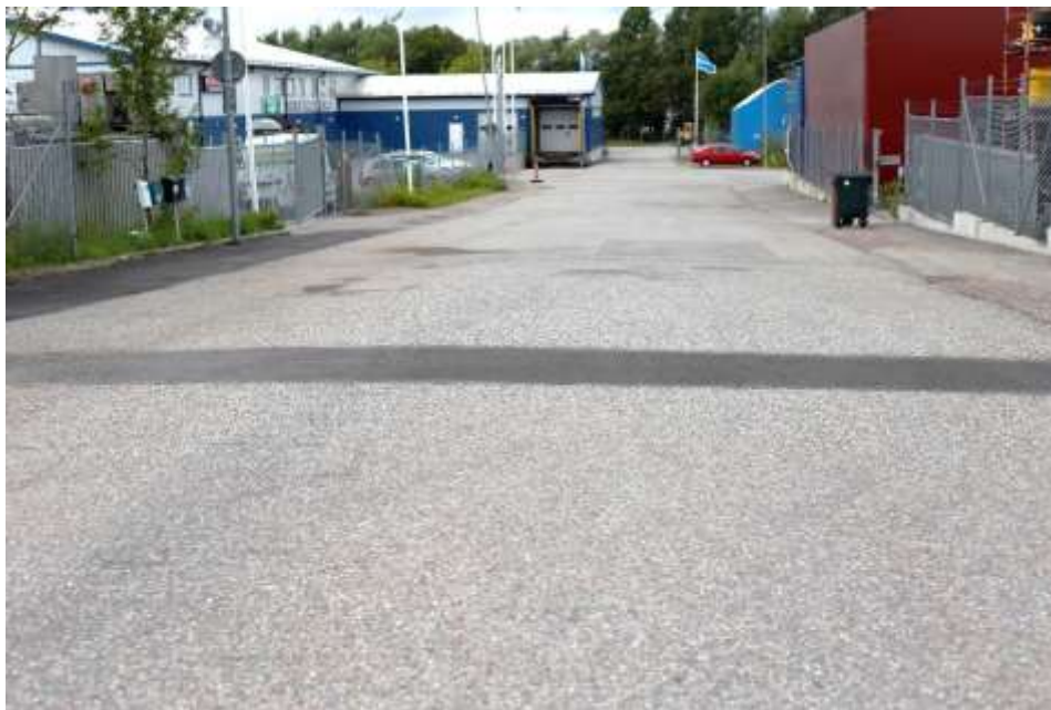
Exempel på återställning av asfalt
