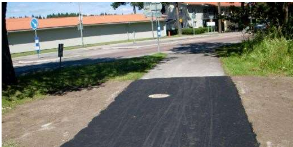
Utgör schakten mer än 50 % av cykel- eller körfältsbredden ska hela bredden återställas.
